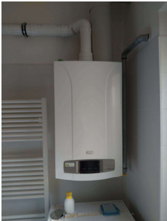
Fig. 1 / 2 – caldaie murali a metano per produzione autonoma acqua calda sanitaria in due diversi alloggi
