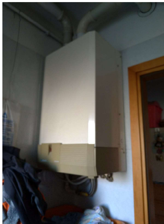
Fig. 1 / 2 – caldaie murali a metano per produzione autonoma acqua calda sanitaria in due diversi alloggi
